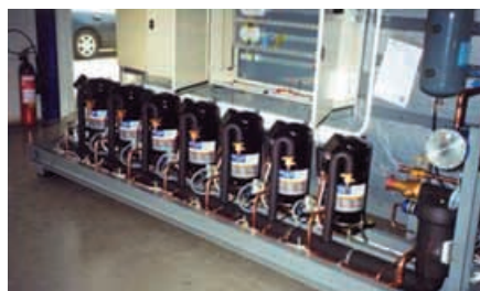
Рис. 2. Система возврата масла с OM3/OM4 TraxOil
