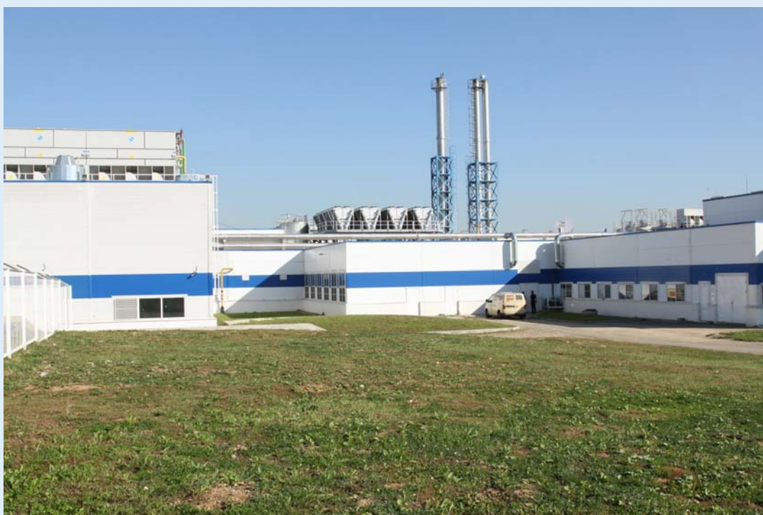
На заводе в Москве действует новая концепция охлаждения для производства ледяной воды
