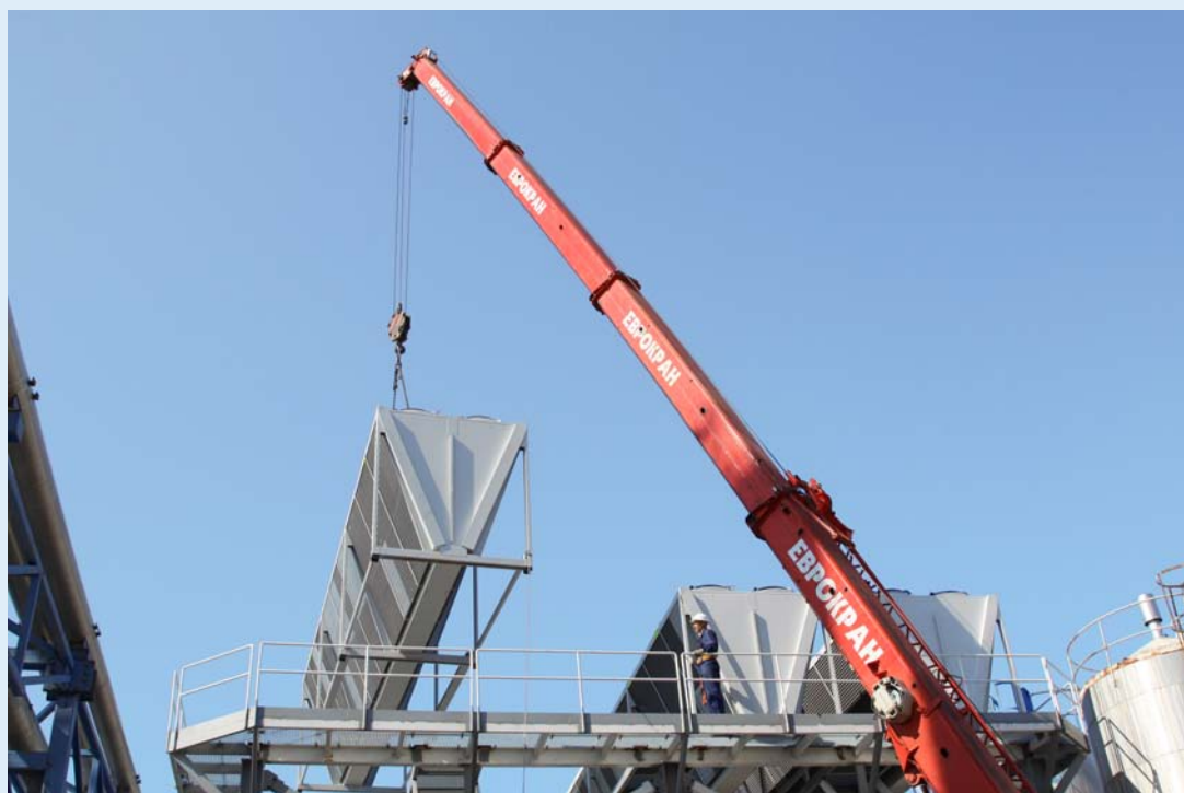
Транспортировка краном без использования траверсы посредством подвижных крановых проушин
