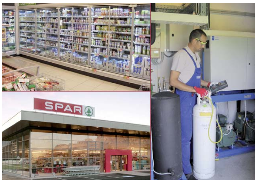
В рамках полевых испытаний, начатых в июле 2010 г., один из магазинов компании «SPAR Österreich» (Зальцбург, Австрия) перевел среднетемпературный агрегат холодильной установки каскадной системы R134a/CO 2 на новый охлаждающий агент производства «Дюпон» – XP10
