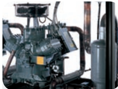
Antivibranti linea mandata e aspirazione del singolo compressore. Vibration dampers on delivery and suction line of each compressor. Joints anti-vibrants ligne de refoulement et d'aspiration pour chaque compresseur simple. Schwingungsdämpfer der Zufluss- und Saugleitung des einzelnen Kompressors. Antivibrantes línea impulsión y aspiración de cada compresor. Виброгасители на линии нагнетания и всасывания на каждом отдельном компрессоре.
