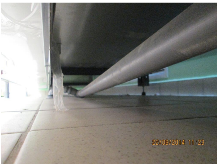
Заужен диаметр трубопровода
