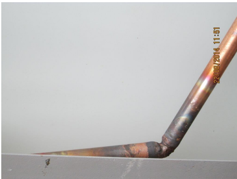
Заужен диаметр трубопровода
