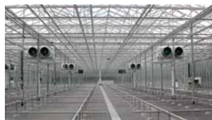
Другая оранжерея, находящаяся в стадии строительства, – в данном случае система оснащается потолочными воздушными теплообменниками.
